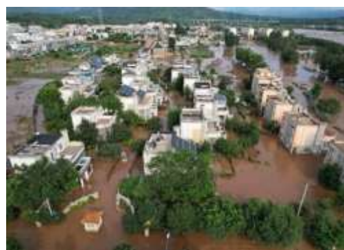
図 2 豪雨により浸水した北京市密雲区の集合住宅(出典:央広網)
