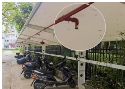
图7. 简易喷淋系统示意图 (出处:网易订阅「电动自行车室外充电桩消防设备整体解决方案」)
